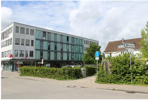
Blick von Nordosten auf das viergeschossige Ärztehaus (außerhalb des Plangebietes), rechts im Bild der Kindergarten, auf dessen Fläche der Bebauungsplan künftig bis zu fünfgeschossige Bebauung zulässt.
